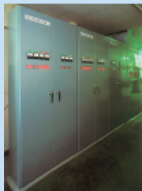
配電盤の組立て
