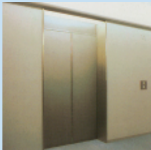
エレベーターパネル補強
